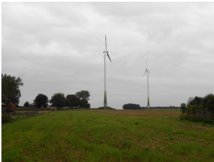
Fot. 10. Elektrownie wiatrowe w Zagrobie. Fot. G. Ferliński, 2017 r.
